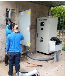
En una operación coordinada y eficiente, se llevó a cabo el proceso de **instalación de transferencia** de energía de 600 amperios, se implementaron 3 polos para conectar la planta eléctrica de 350 kW
